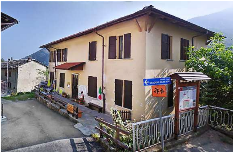
Casa Alpina "E. Ostorero", ex scuola elementare di borgata Ferria
